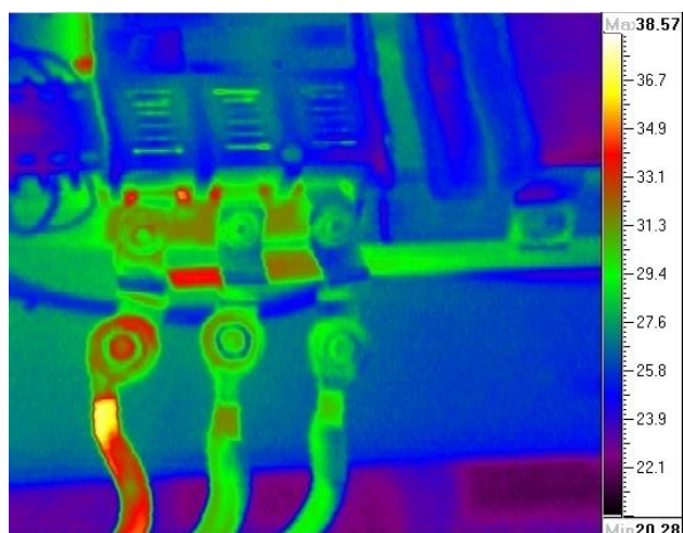
Рисунок 21. Пример термограммы контактных соединений с температурной шкалой
